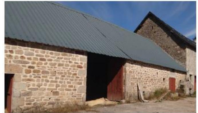
*Toiture en bac acier à joint debout, teinte proche gris basalte (RAL 7011)*
