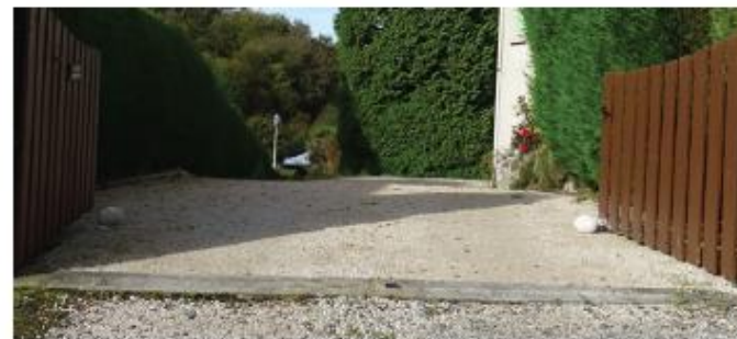
Revêtement de sol perméable : gravillonné stabilisé
