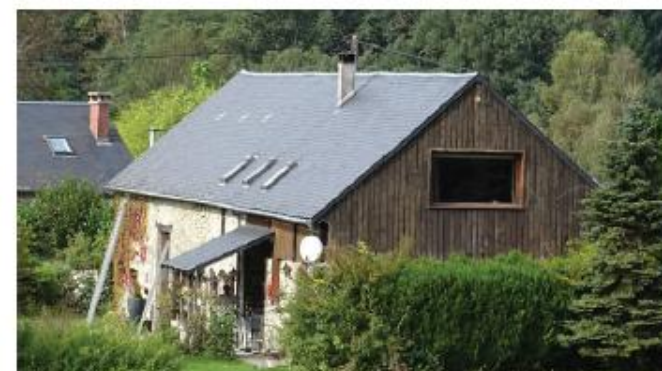
L'habillage en bois d'une façade ancienne permet par exemple une bonne intégration d'une isolation par l'extérieur
