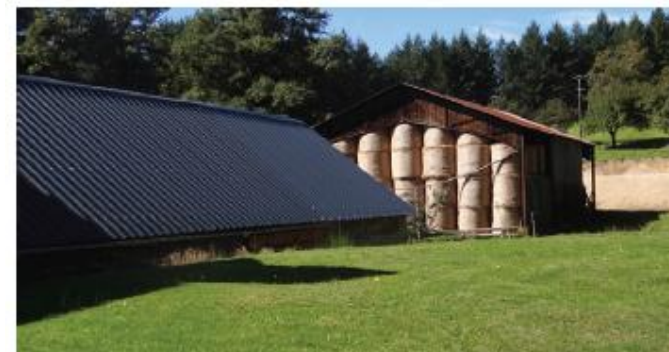
Bâtiment intégré dans la pente, toiture en bac acier à joints debout, teinte proche gris anthracite (RAL 7016)
