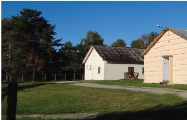
Revêtement de sol perméable : voie de circulation en gravillonnés et abords enherbés
